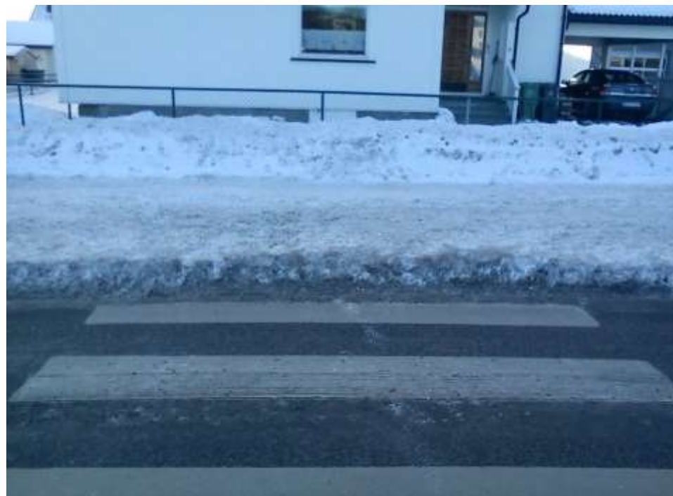
Figur 24 Bildet er hentet fra Luksefjellvegen i Skien vinter 2013. Gangfeltet ble oppgradert sommer 2012 med taktil merking. Om vinteren blir merkingen dekket av is og er umulig å se eller kjenne. Terskelen blir høyere.
