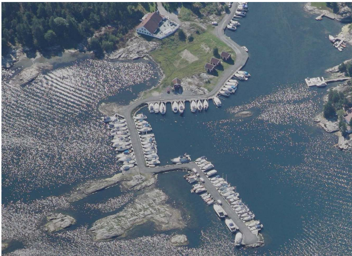
Figur 6. Skråbilde fra nord. Sjøterrassen og båthavn
