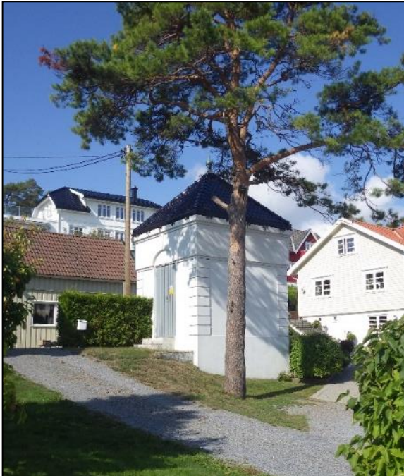
Figur 6.20: Gammel trafostasjon (foto: Asplan Viak)
