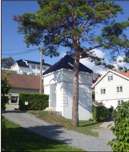
Figur 6-21: Gammel trafostasjon (foto: Asplan Viak)
