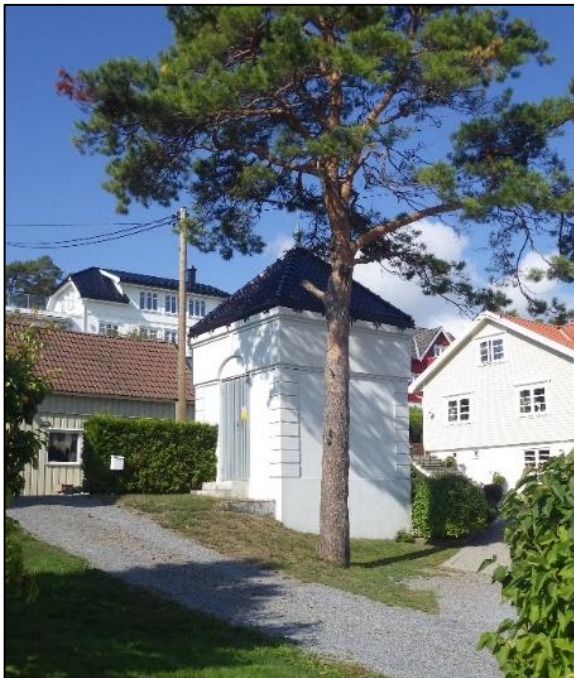
Figur 6.10: Gammel trafostasjon (foto: Asplan Viak)
