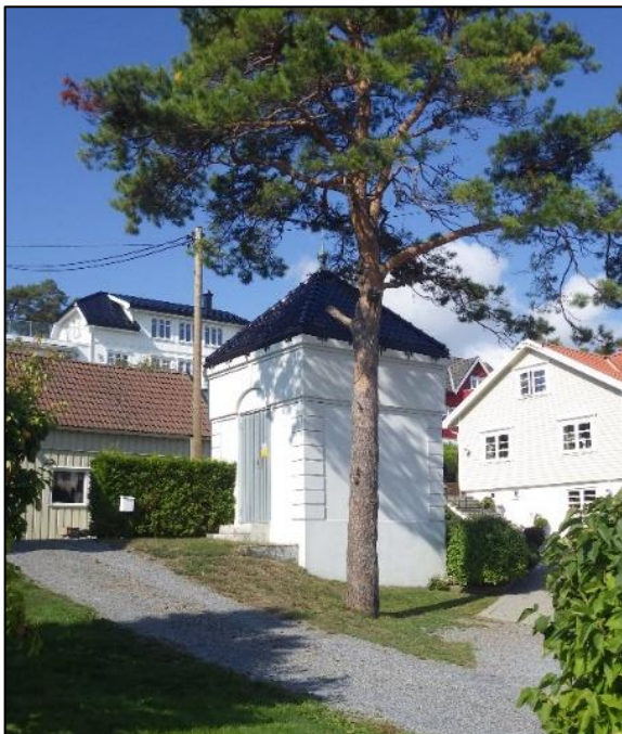
Figur 6.16: Gammel trafostasjon (foto: Asplan Viak)
