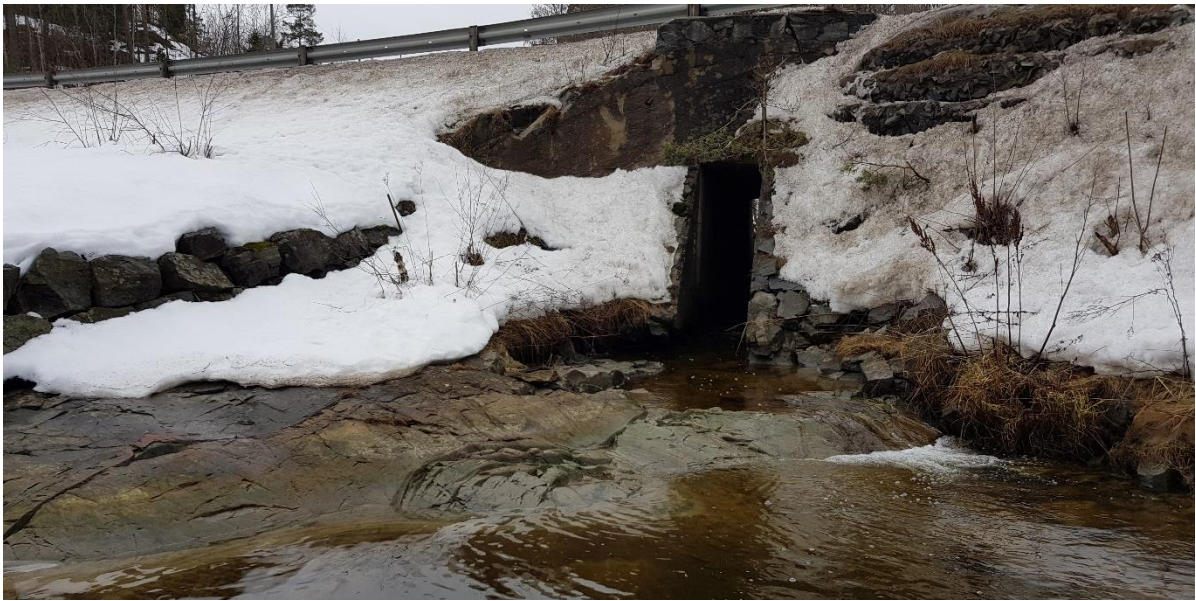
Figur 7: Kulverten under fylkesveien i nedre deler
