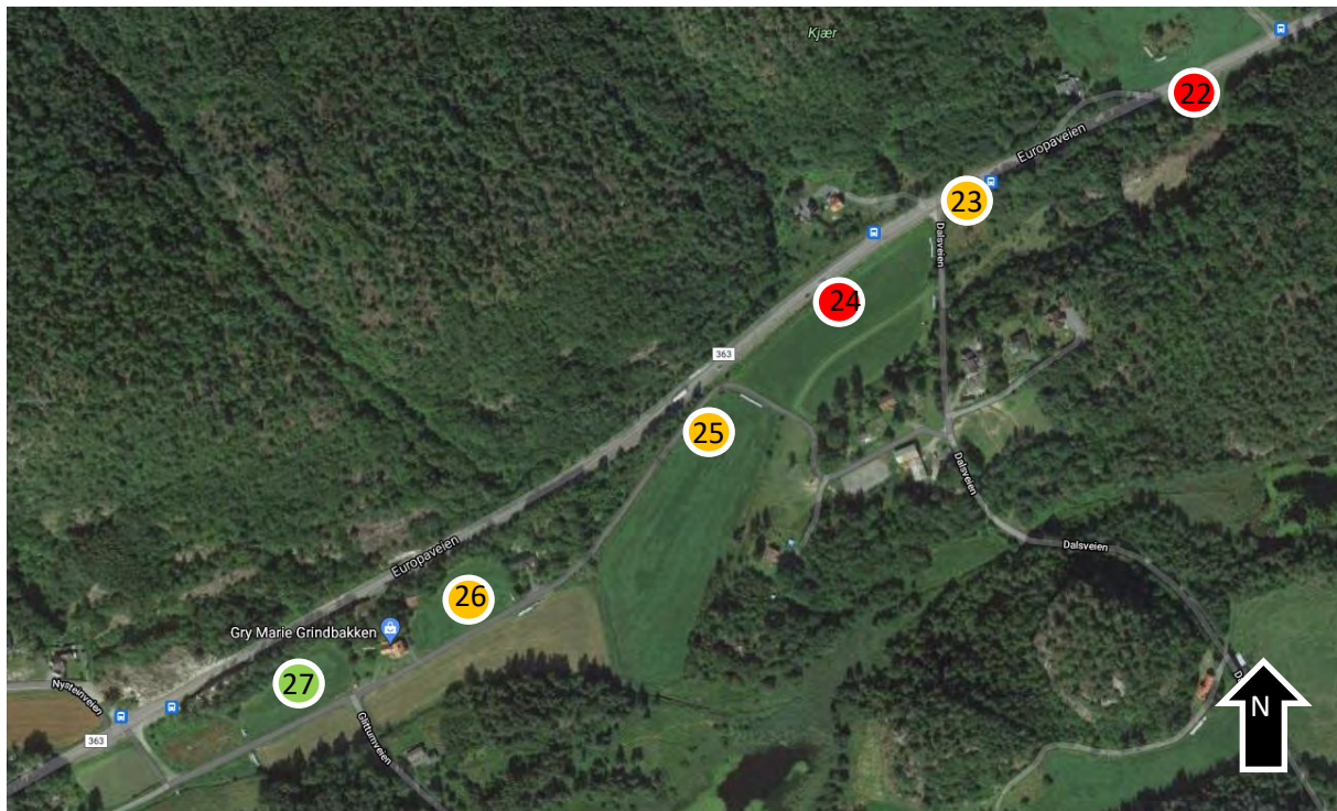
Figur 12: Flyfoto over delprofil 1000-1900 med omtrentlig plassering av totalsondering 22-26 sør for Fv363. Maks fyllingshøyde er ca. 4-5 m ved profil 1250, iht. mottatt dwg. underlag.
