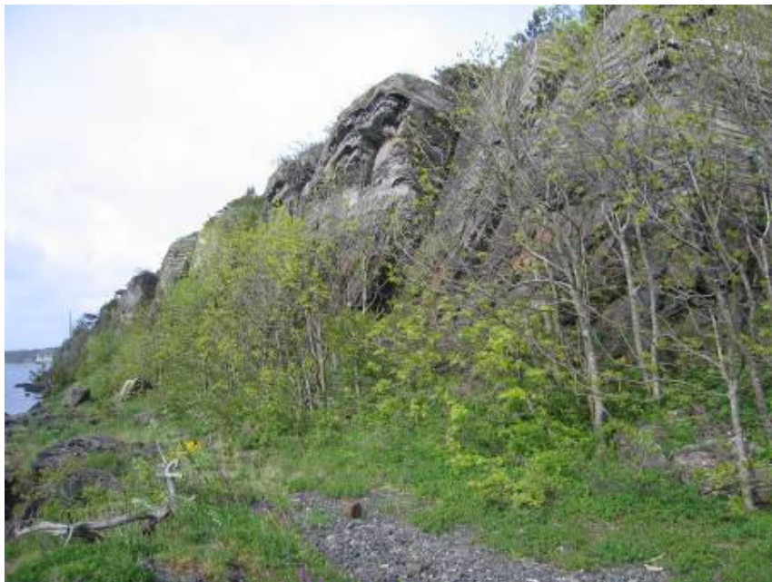
Figur 36 Loddrette kalkberg med rødlistede kalklav som er i ferd med å skygges ut av ung askeskog som snarest bør ryddes. Fra vestsiden av sone 3. Foto: Sigve Reiso.
