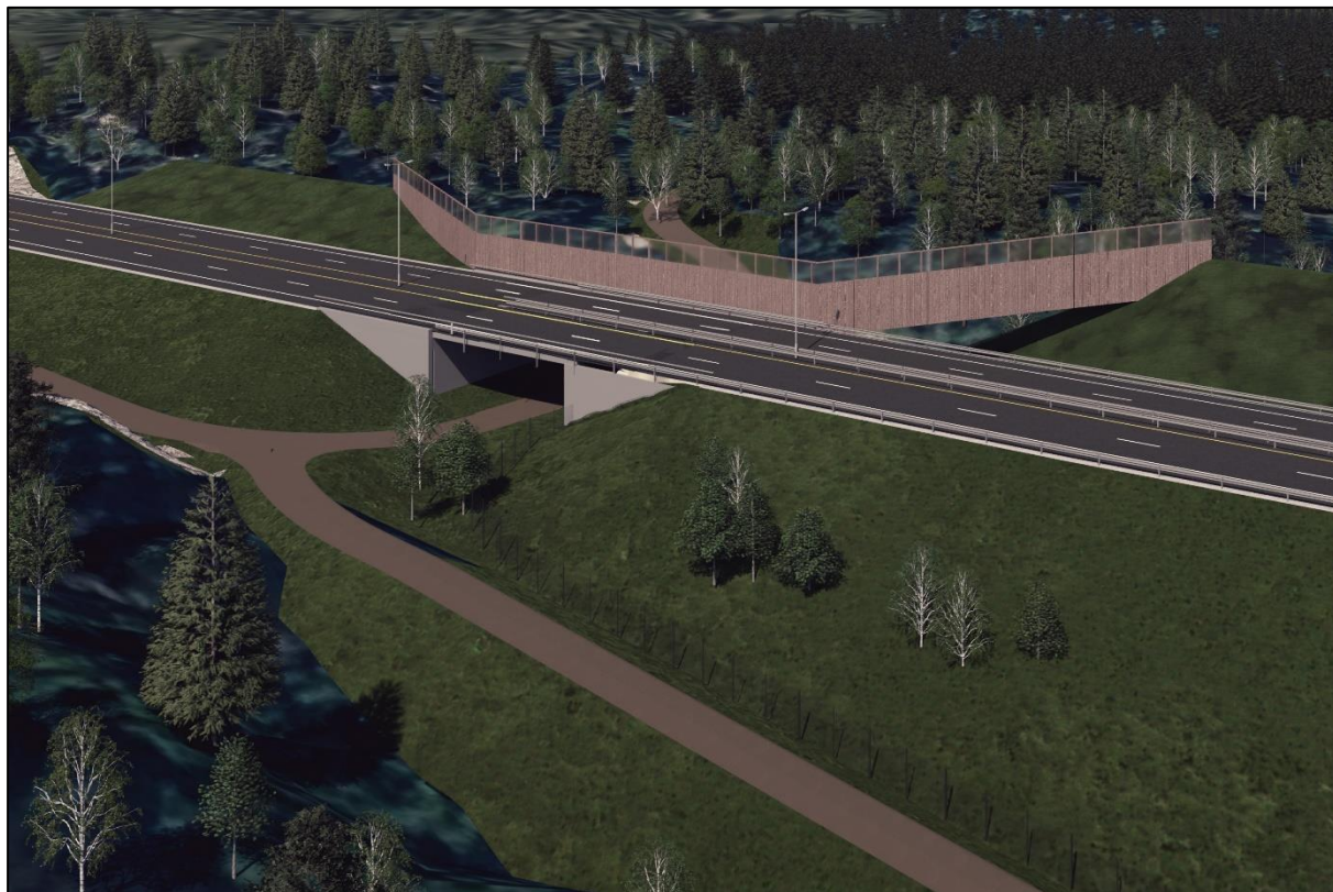
Figur 3-18: Brynemo I kulvert med støyskjerming og støyvoll, sett fra vest. (Kilde: Sweco)
