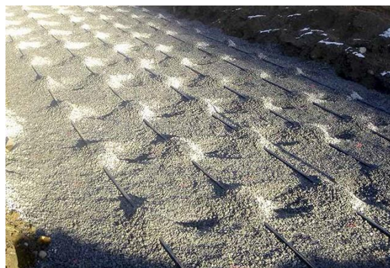
Eksempel på bygging av nytt avløpsanlegg.
