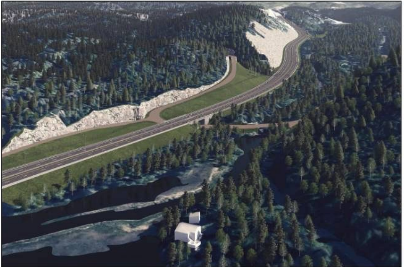
Figur 3-50: Tiltak ved Dørdal og Hanfangåsen, sett fra sør. (Kilde: Sweco)
