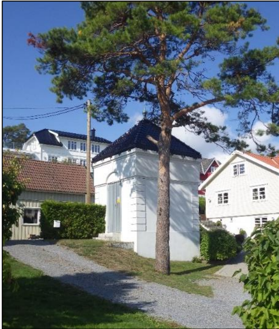
Figur 6.16: Gammel trafostasjon (foto: Asplan Viak)
