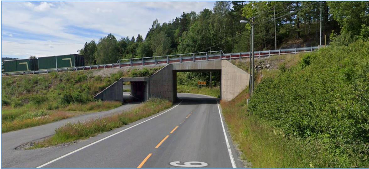
Figur 4-9 Fv. 3688 med eksisterende konstruksjon som krysser under E18 ved Østerholt.
