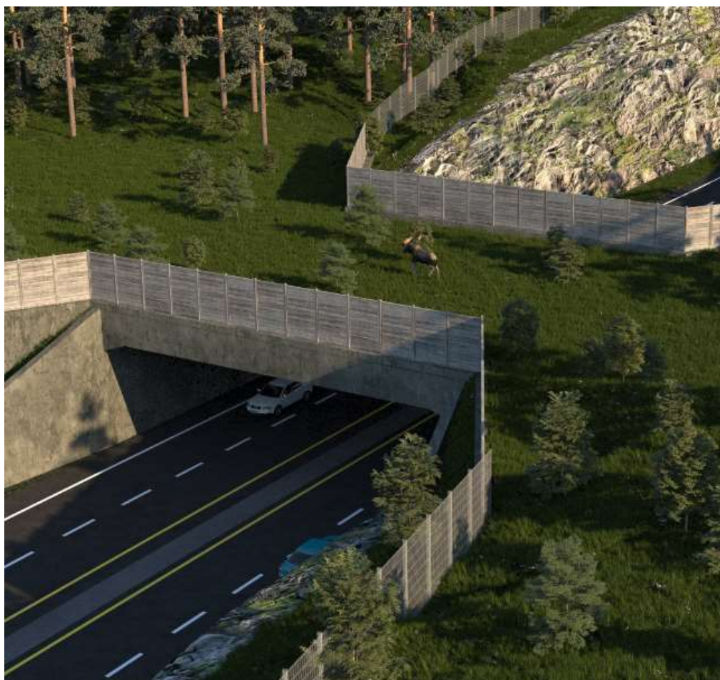
Figur 11: Eksempel på viltovergang.
