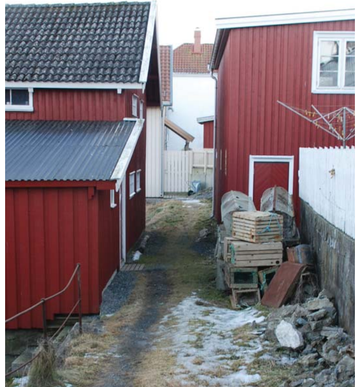
Langesund er en ryddig by, men også her finnes det eksempler på lagring av ting som kan tennes på og som ligger tett innpå verneverdig bebyggelse.
