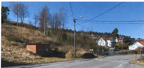
Figur 17: Eksisterende boliger i BFS1, nettstasjon (BE) og garasje (BG)
