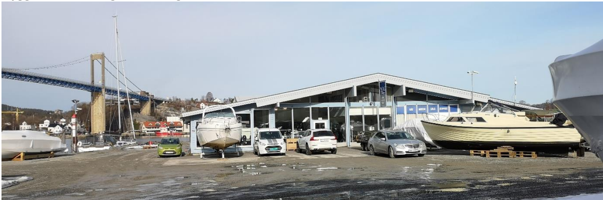
Bilde 52: Eksisterende bygg for forretning, verksted og kontor
