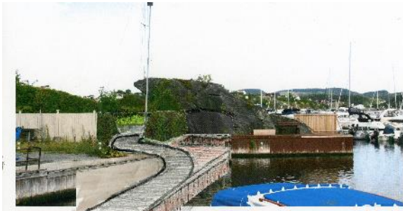
Fig 25: Den justerte gangveien sett fra sør
