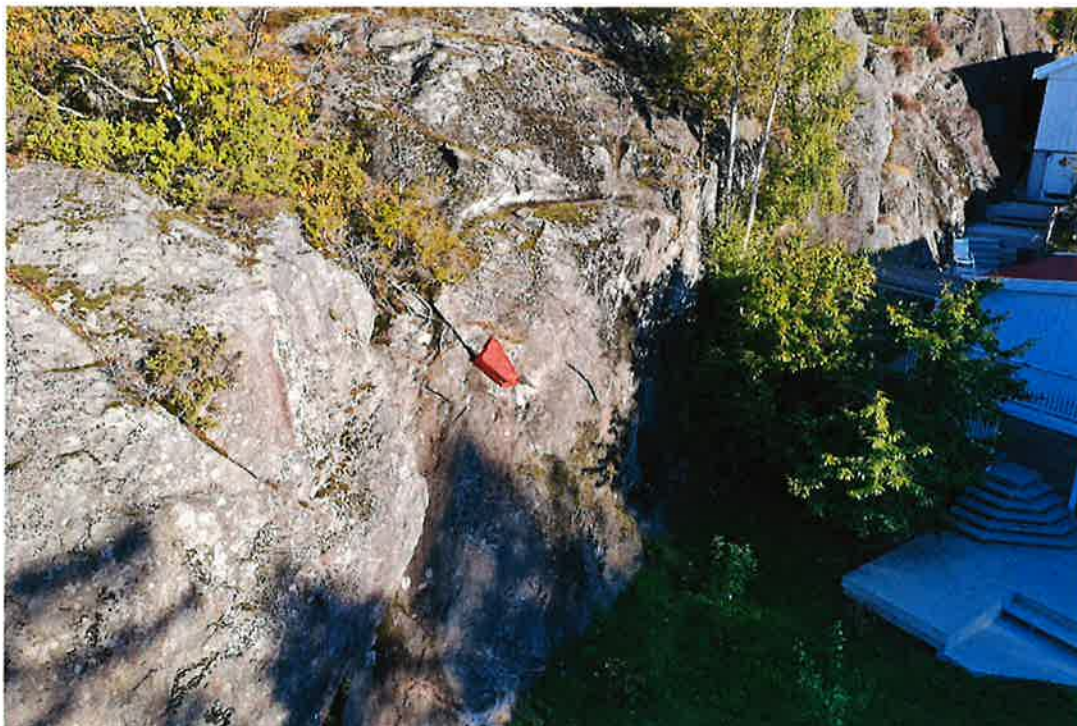
Figur 5. Avløst blokk ovenfor hagen er markert med rødt, og anbefales å renskes ned, eller sikres med bolt.
