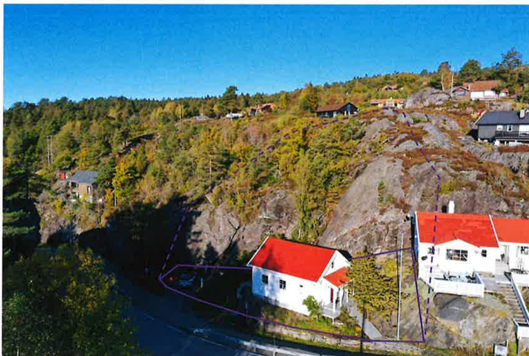
Figur 3: Dronefoto av det kartlagte området. Kartleggingsområdet (tomten) er vist med heltrukket lilla polygon, mens påvirkningsområdet er vist med stiplet linje.
