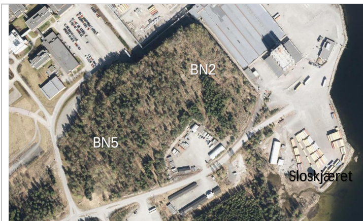
Figur 5-3 Kolle innenfor planområdet som sprengt vekk
