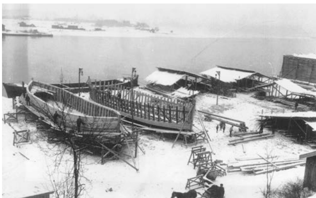
Fig 16 Knarrdalsstrand lektrebygging i Porsgrunn rundt år 1900. (Porsgrunn Bymuseums arkiv).
