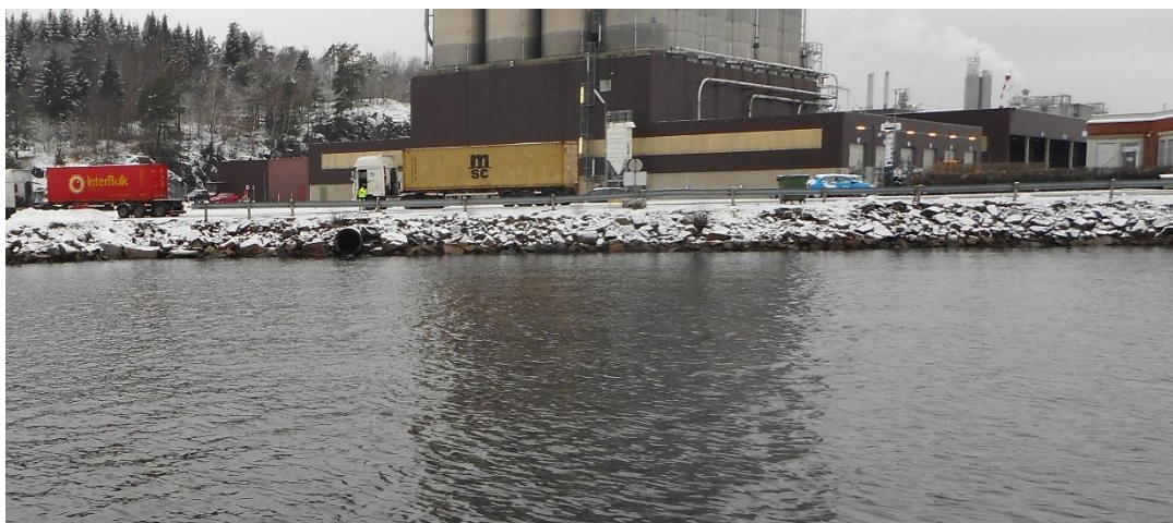
Figur 5: Utløp/kulvert av ukjent opphav fra Rønningen industriområde. Bildet tatt ca. fra sedimentstasjon 7.
