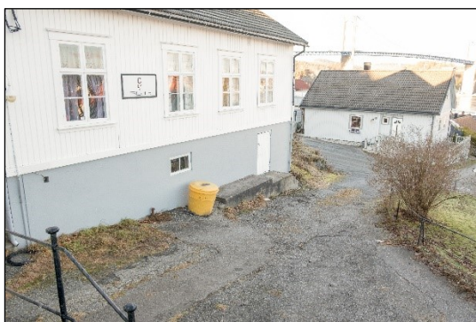
Figur 19: Bilde av Bedehusets fasade mot øst.
