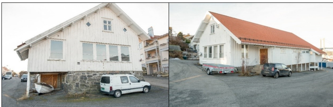
Figur 20: Skolebyggets fasade sett mot sør og mot nordvest.
