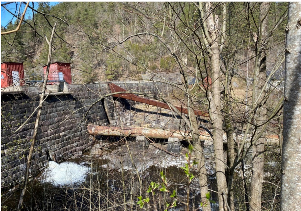
Figur 7: Kongens dam sett fra sørøst med rørgate og tømmerrenne.
