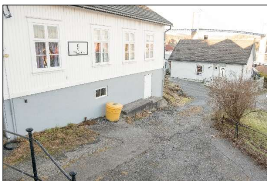
Figur 19: Bilde av Bedehusets fasade mot øst.
