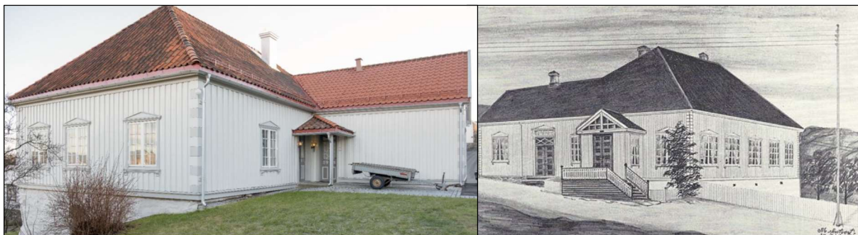
Figur 16: Bilde av dagens inngangsparti sett fra nord og tegning fra 1916 sett fra sør.
