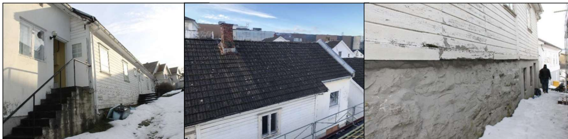
Figur 18: Bilder av fengselet sett ved inngang i vest og fasade og tak sett fra øst
