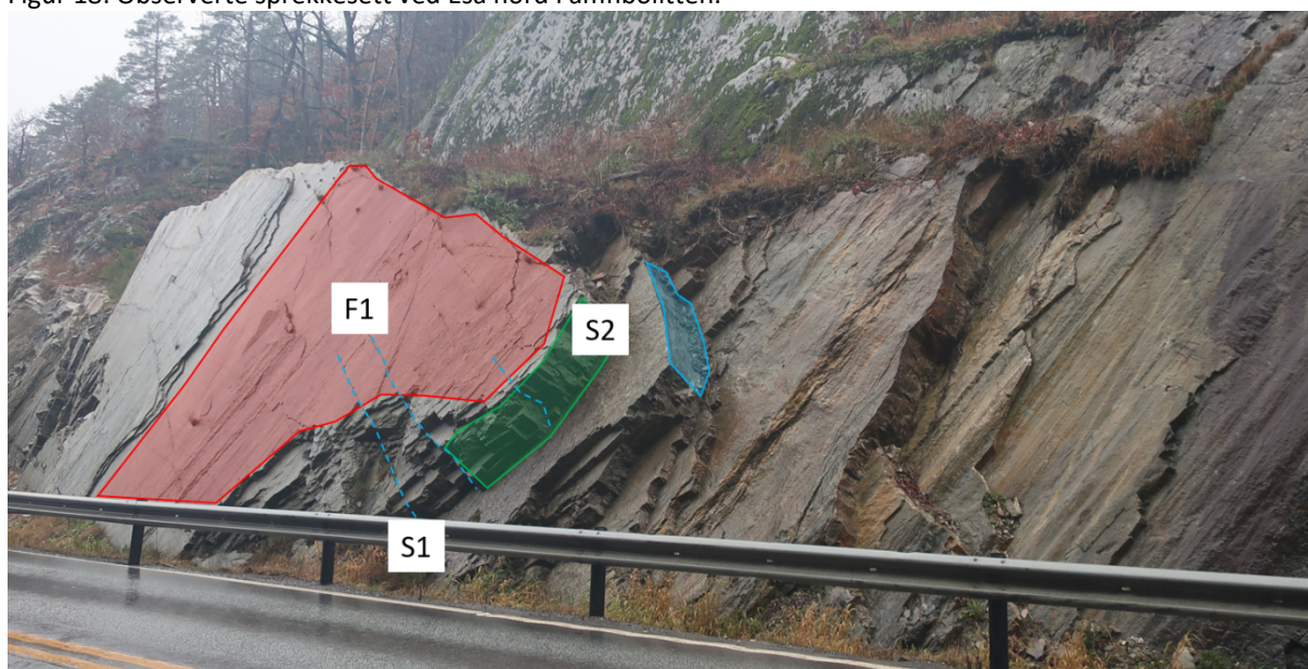
Figur 19: Observerte sprekkesett ved Esa nord i kvartsitten.
