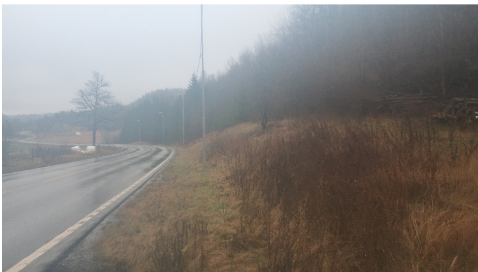
Figur 32: Foto fra befaringsdagen som viser topografien ved profil 160-270. GSV legges på høyre side av veg.
