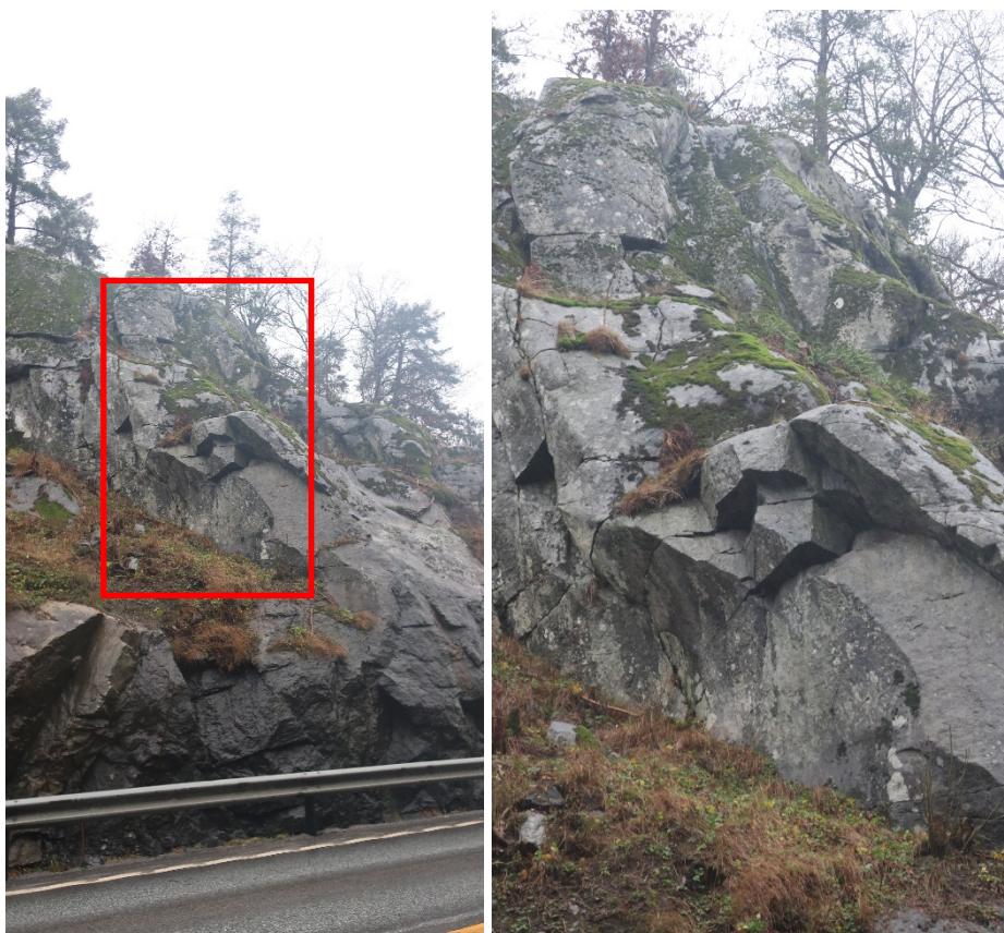
Figur 23: Oversiktsbilde i amfibolitten som viser sidebratt skrent med løse blokker i overkant.
