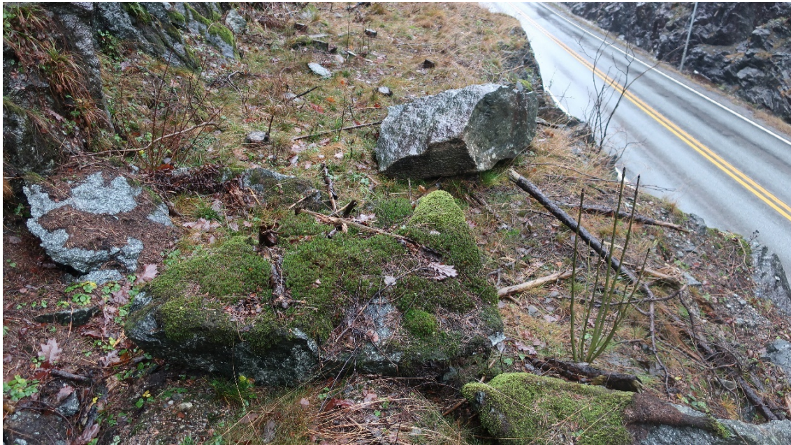
Figur 30: Blokke nedfall ved profil
