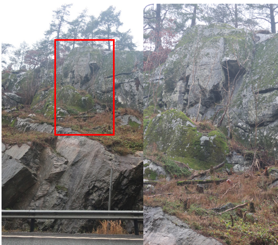
Figur 22: Oversiktsbilde i amfibolitten som viser sidebratt skrent med løse blokker i overkant.
