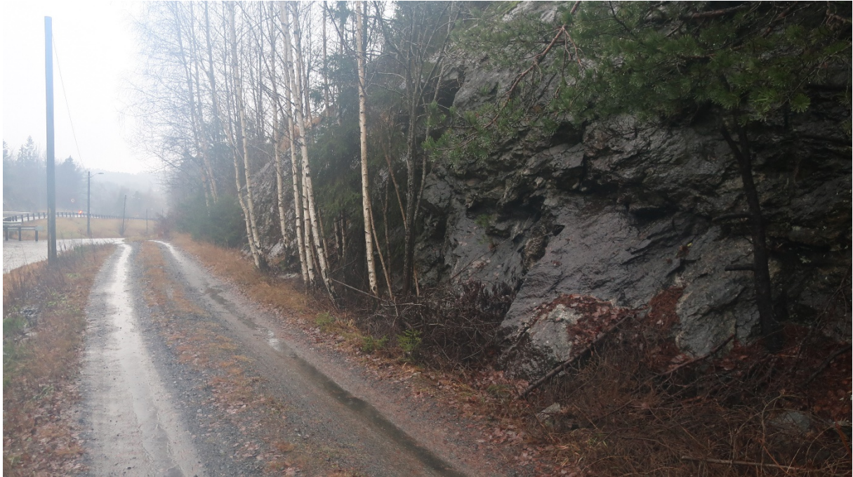
Figur 31: Foto fra befaringsdagen som viser eksisterende bergskjæring ved profil 1750-1800.
