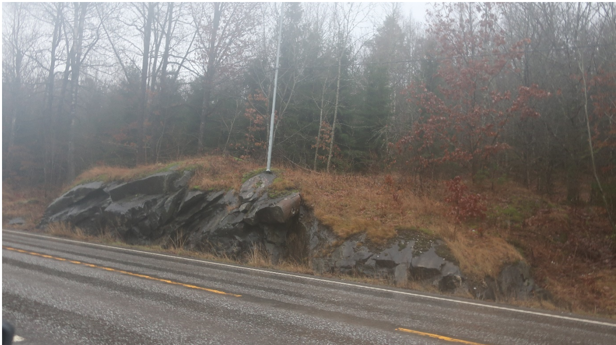
Figur 33: Foto fra befaringsdagen som viser bergblotning ved profil 930-970.
