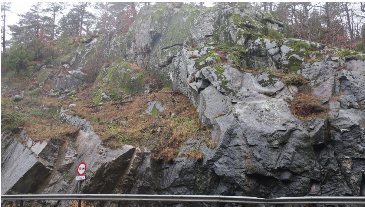
Figur 58: Nordre del av bergskjæring ved Esa nord 2.
