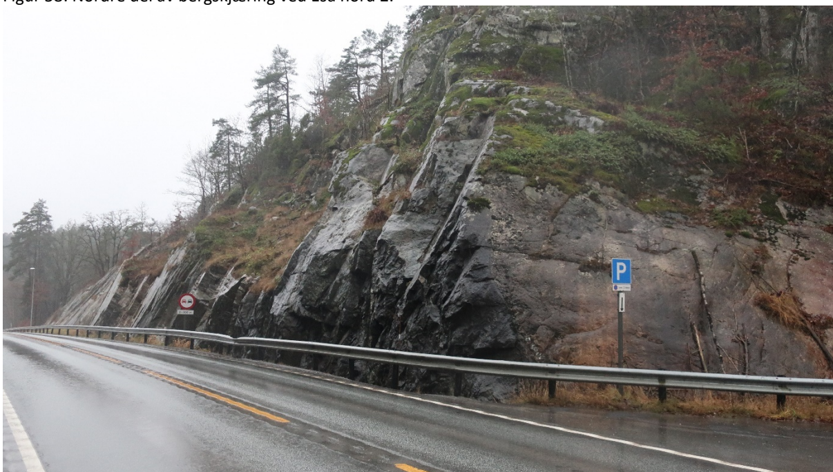
Figur 59: Sett mot sør.
