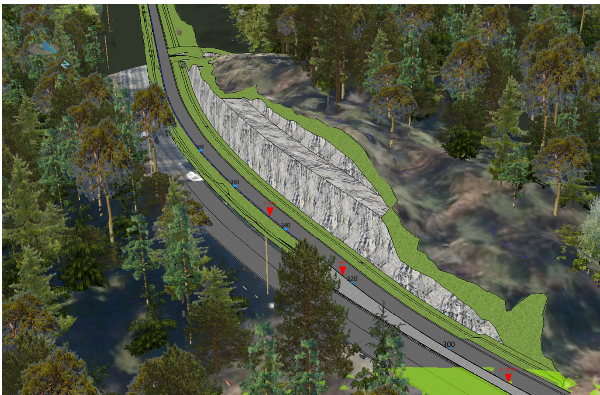
Figur 40: 3D-modell av ferdig utsprengt bergskjæring ved Bamble Prestegård.
