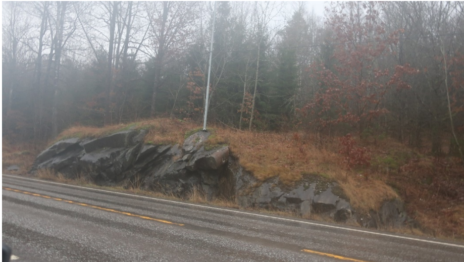
Figur 81: Eksisterende bergknaus ved Lillebrekka 1.
