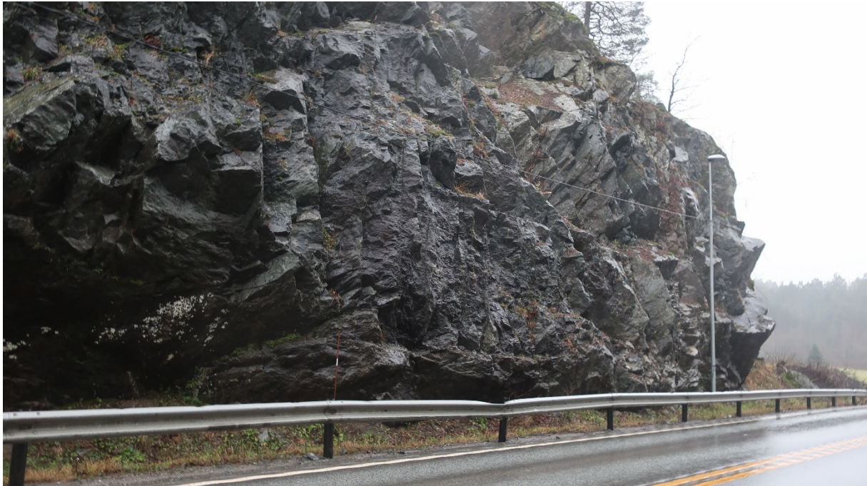
Figur 62: Bergskjæring på motsatt side av veg ved Esa nord 2.
