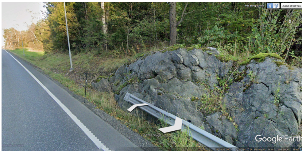
Figur 84: Eksisterende bergknaus ved Lillebrekka 2
