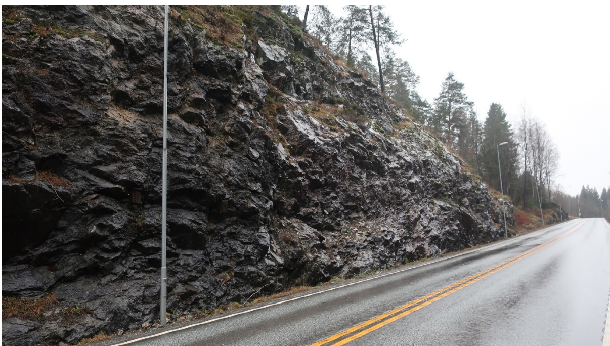
Figur 71: Bergskjæring på motsatt side av veg ved midtre del av Esa sør 1. Sett mot sør.
