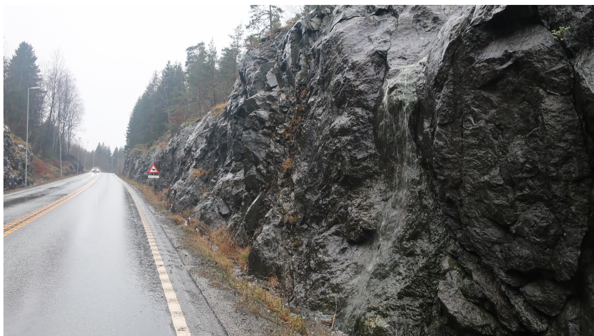
Figur 65: Nordre del av bergskjæring ved Esa sør 1, sett mot sør.
