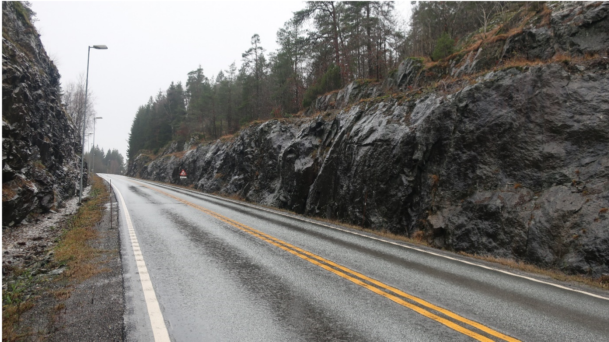
Figur 66: Sett mot sør.
