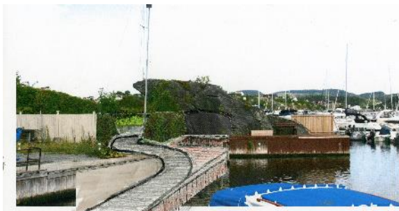
Fig 25: Den justerte gangveien sett fra sør
