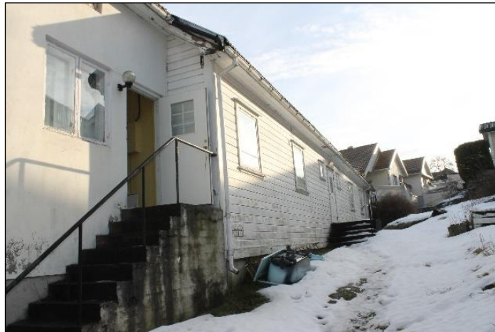
Figur 19. Fengelets bakside med nyere tilbygg og trapp. Foto Norconsult 2018.
