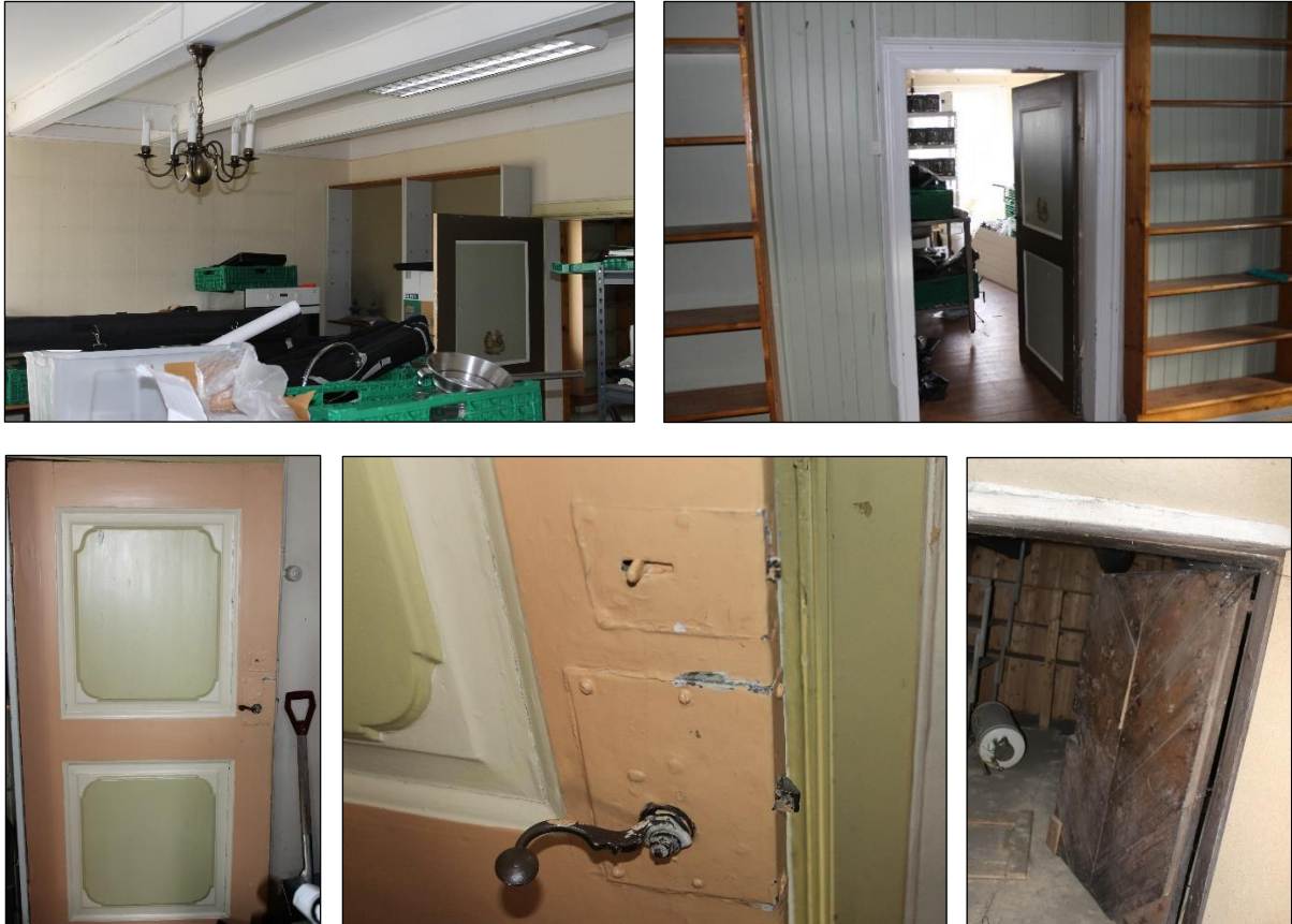
Figur 15. Foto av elementer med kulturhistorisk verdi, synlige bjelker i himling, eldre panel, opprinnelig dør med eldre lås og vrider, samt opprinnelig labankdør i kjeller. Foto Norconsult 2018.
