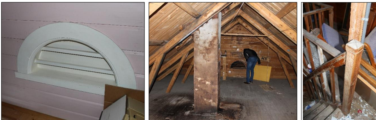
Figur 21. Fengselet. Opprinnelige åpninger i den opprinnelige gavlveggen, opprinnelige/eldre trapp med gelender. Foto Norconsult 2018.
