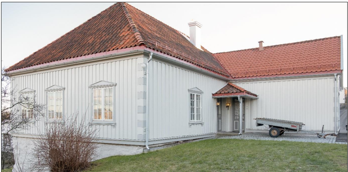
Figur 14. Fogdegården med dagens hovedinngang på baksiden av huset. Foto Norconsult 2018.
