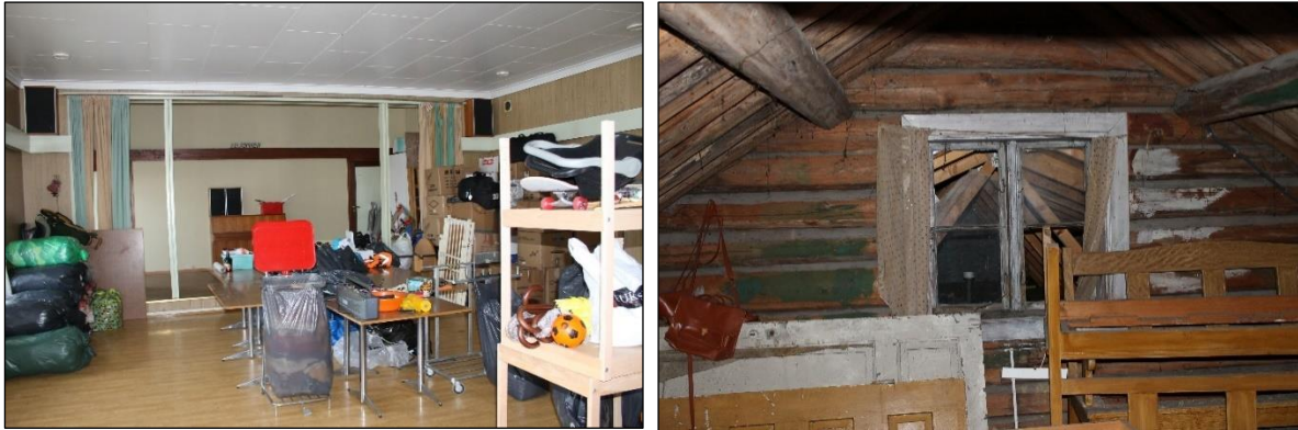
Figur 18. Velhuset, forsamlingshall og eldre vindu mellom nyere og gammel del. Foto Norconsult.2018
