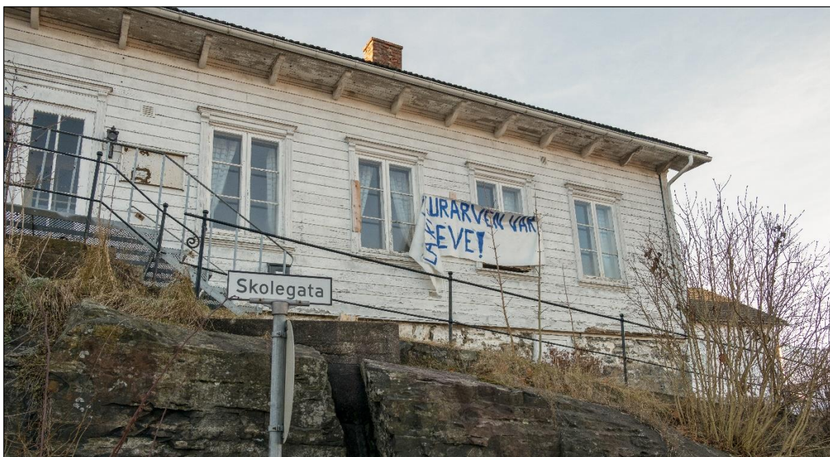
Figur 17. Velhuset før rehabilitering i 2018. Foto Norconsult 2016.
