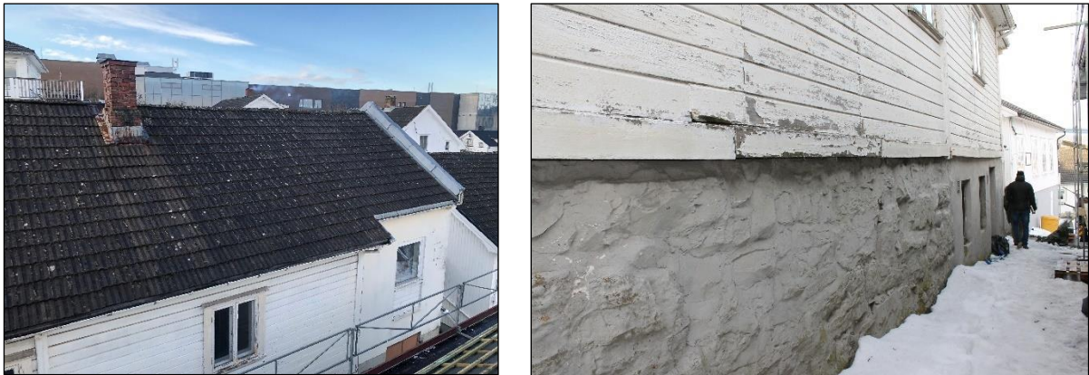
Figur 20. Fengselets takflate og grunnmur. Norconsult 2018.
