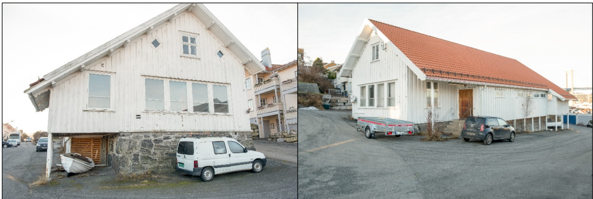
Figur 9: Skolebyggets fasade sett mot sør og mot nordvest.
