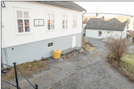
Figur 8: Bilde av Bedehusets fasade mot øst.
