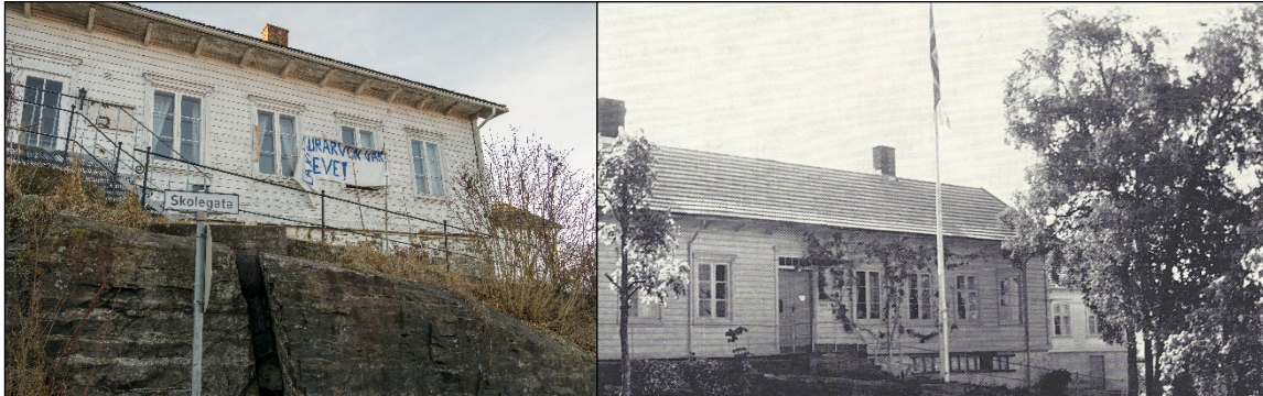
Figur 6: Velhuset før rehabilitering i 2018 og historisk bilde fra 1864 like etter bygget ble reist.
