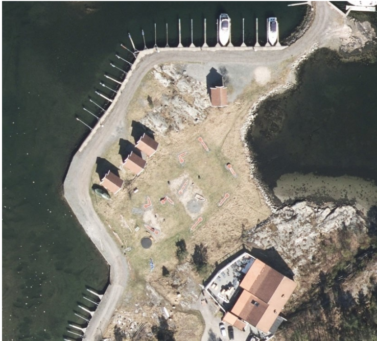
Figur 24 Flyfoto med dagens situasjon
