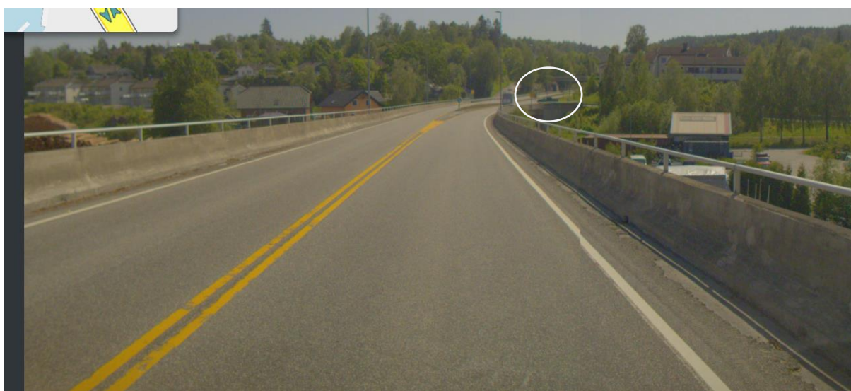
Figur 1-9: Bilde fra Herreveien mot kryssområde (sikt mot bil i Rafnesveien) (Kilde: Vegkart.no, juni 2021)
