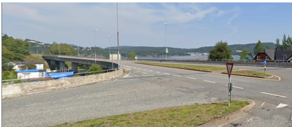
Figur 2-2: Rekkverk på brua nordlig retning (Kilde Google Street View, juli 2019)
