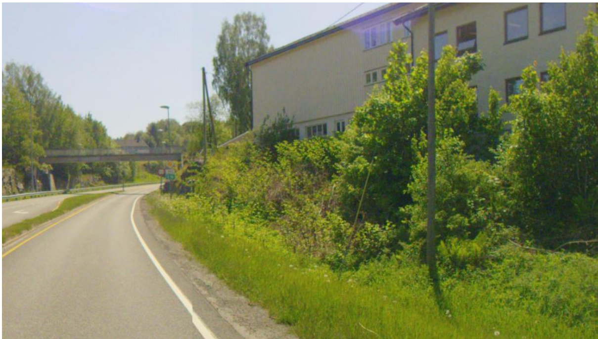
Figur 2-1: Vegetasjon og fjellskjæring langs Herre skole (Kilde: Vegkart.no, juni 2021)
