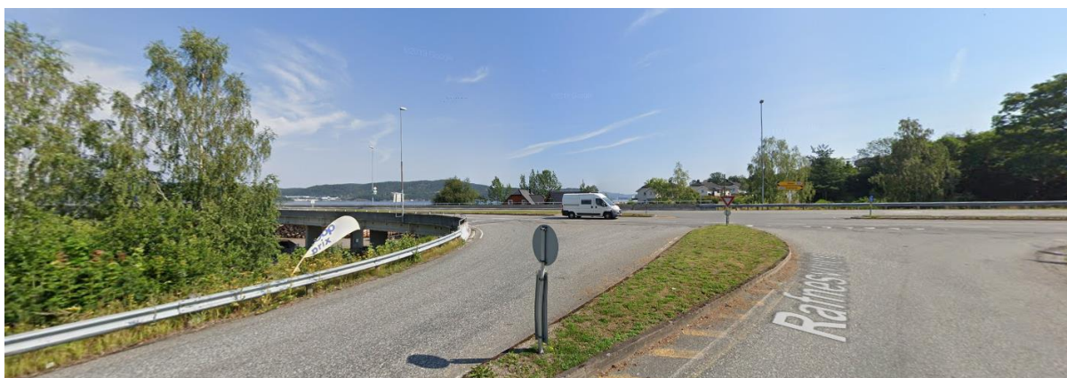
Figur 2-3: Vegetasjon i nordlig retning før krysset (Kilde Google Street View, juli 2019)
