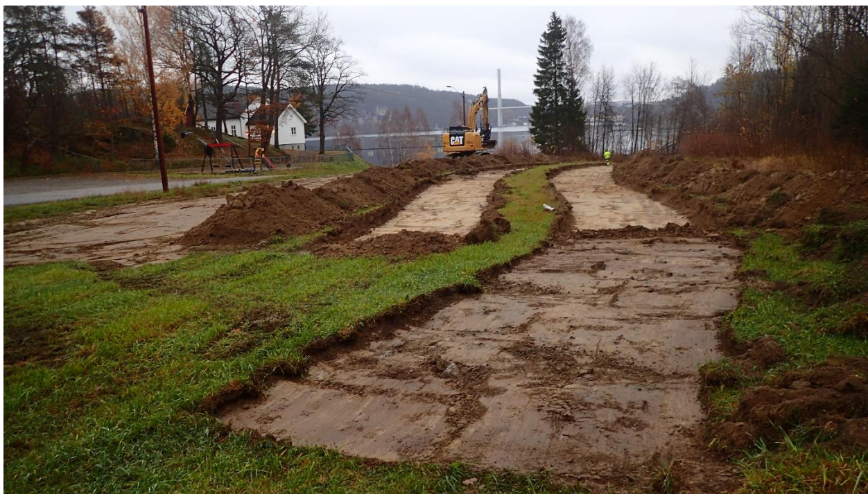
Foto 11: Oversiktsbilde fra området ved Havreåker (gnr./bnr. 16/1) under tilbakefylling av sjaktene. Foto tatt mot øst (Foto: David Hill)
