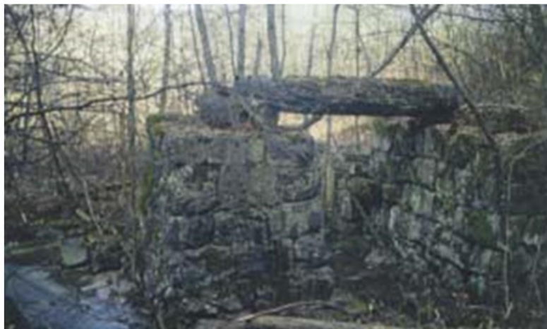
Figur 44 Rester av fundament for sag ved Søtholtbekken.
