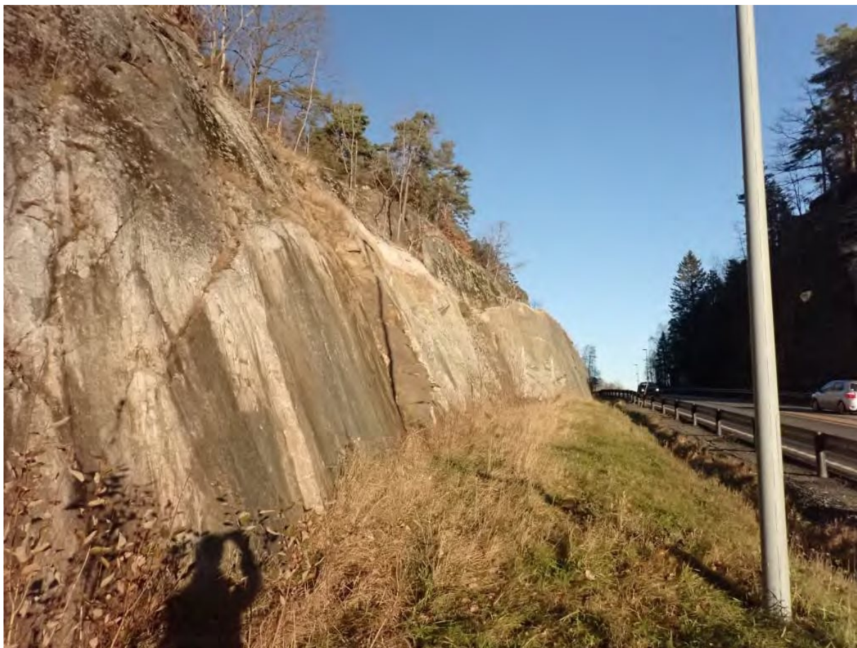
Figur 7. Glattskurte bergvegger av granitt ved Storås.
