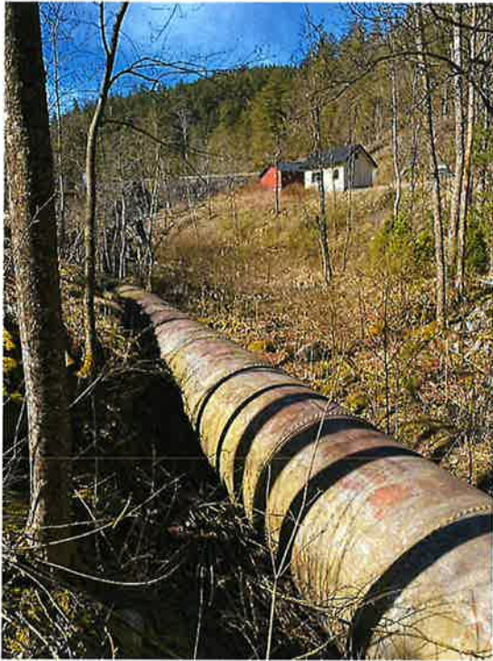
Figur 10: Rørgata/ turbinrøret
