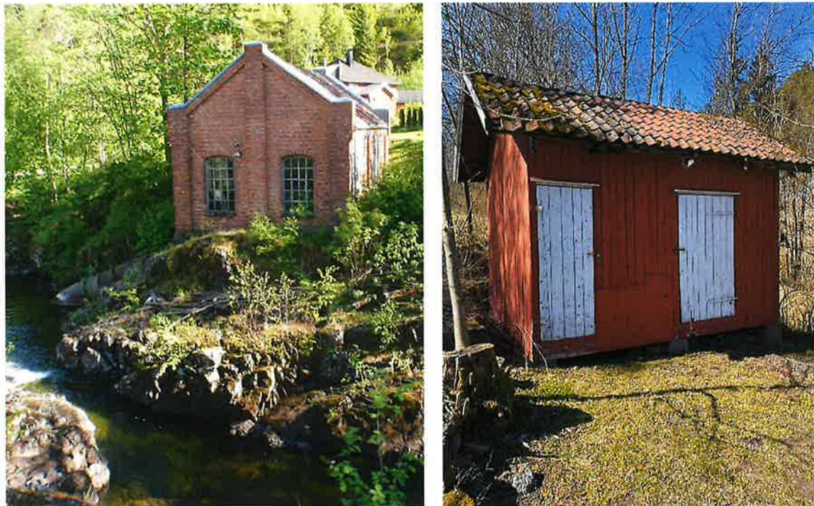
Figur 9: Kraftstasjonen sett fra nord og skjulet på oppsiden sett fra kraftstasjonen.
