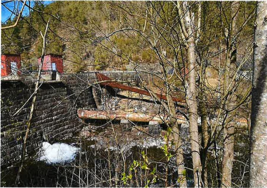
Figur 4: Kongens dam sett fra sørøst med rørgate og tømmerrenne.
