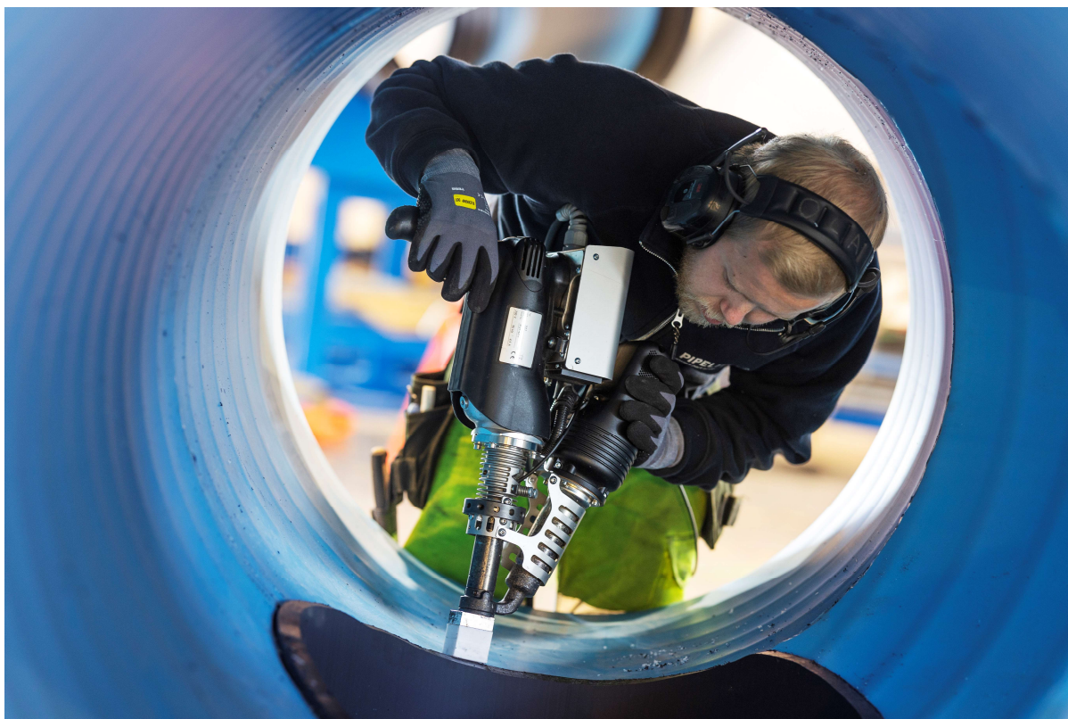
Foto: Pipelife Stathelle
